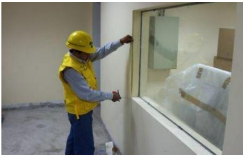
Figura 9.18. Montaje del visor de una sala de tomografía.
